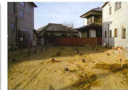
くい打設後もきれいな現場
