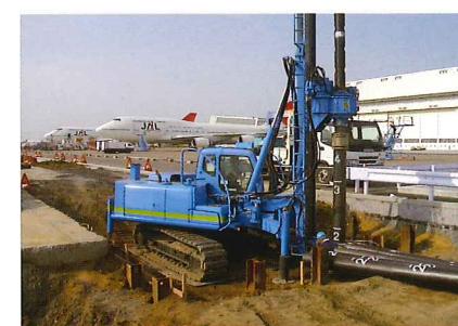
大型工事も安心施工
