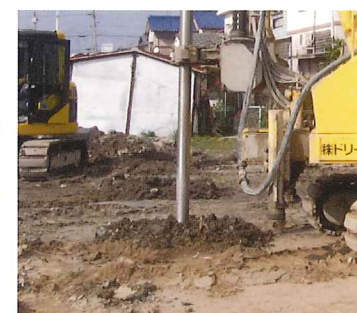
3 削孔完了
