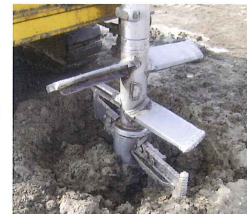
2 注入混合攪拌状況
